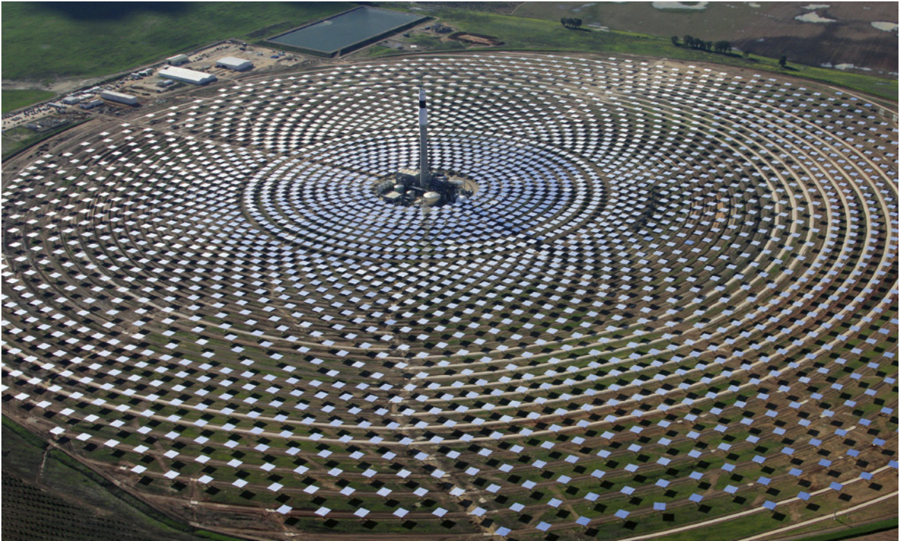
BASF aporta nitrato sódico a la planta de energía solar por concentración Gemasolar, propiedad de Torresol Energy, ubicada en Sevilla.
